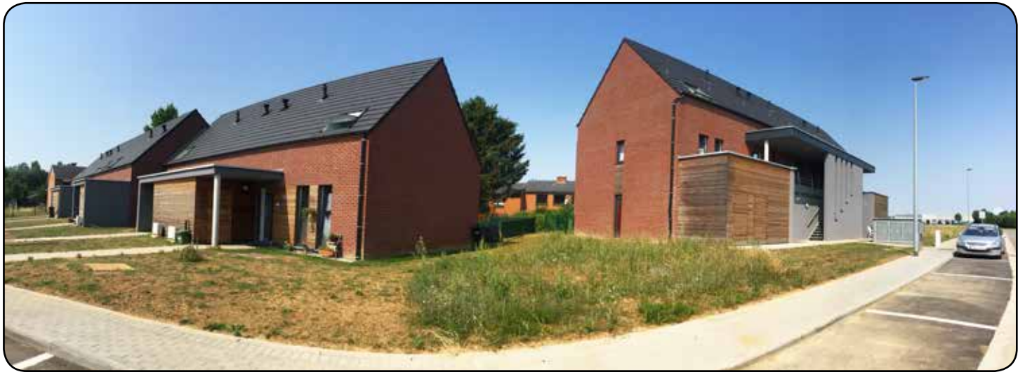
10 nouveaux logements publics à Frasnes-lez-Gosselies
